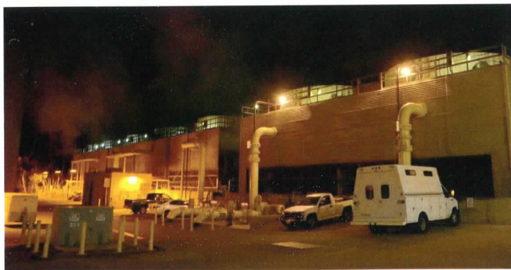
UCSDの30MWガスタービン式コジェネレーションシステム。 冷水は約1万4千立方メートルのチラーユニットに保管
